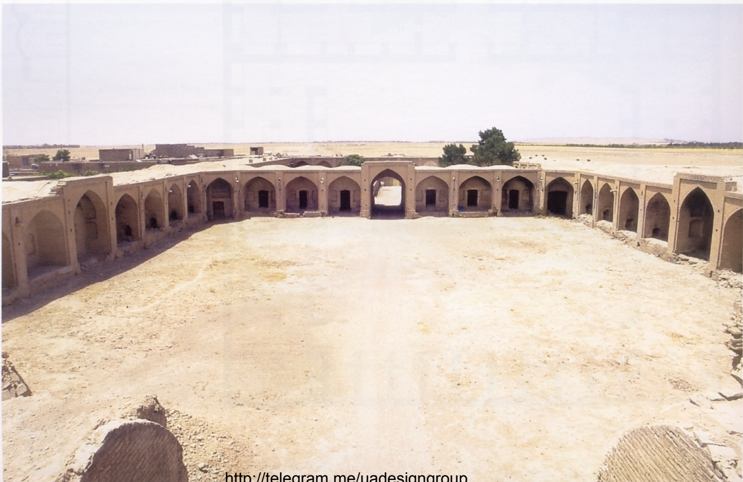
۳۰. نمای شمالی حیاط جنوبی
