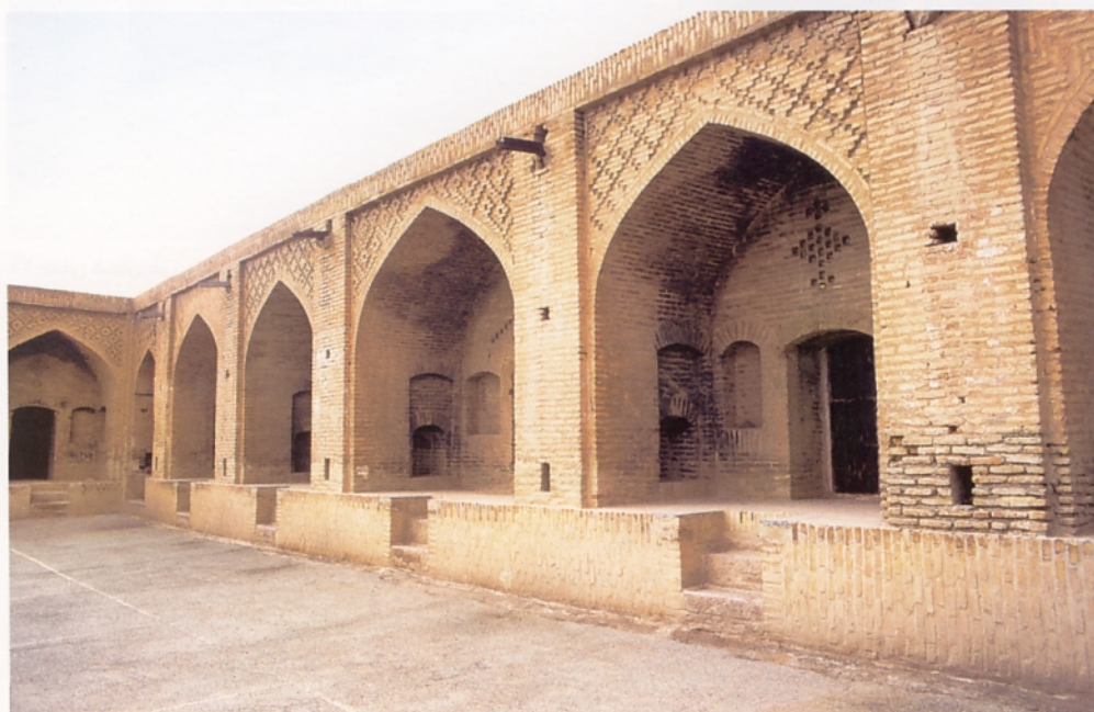
۲۴. جبهه جنوب غربی حیاط
