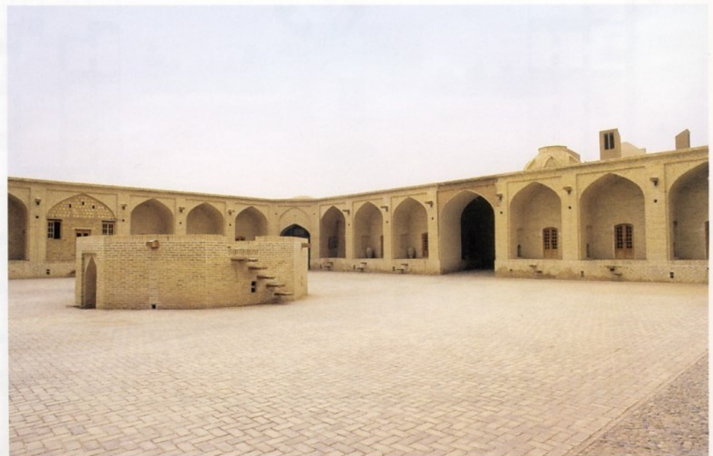
۱۱۱. جبهه جنوبی 111. Southern side
