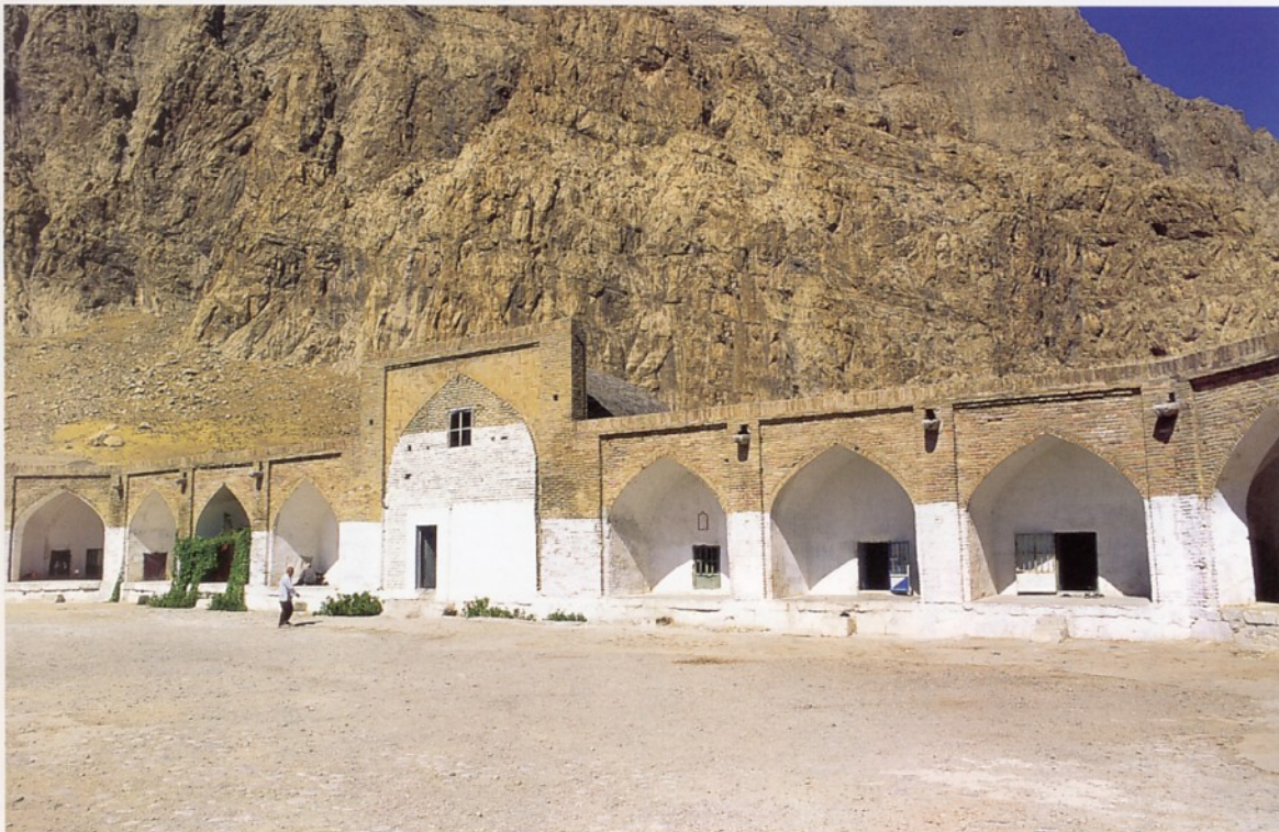
۹۳. جبهه شمالی حیاط 93. Northern side of the courtyard
