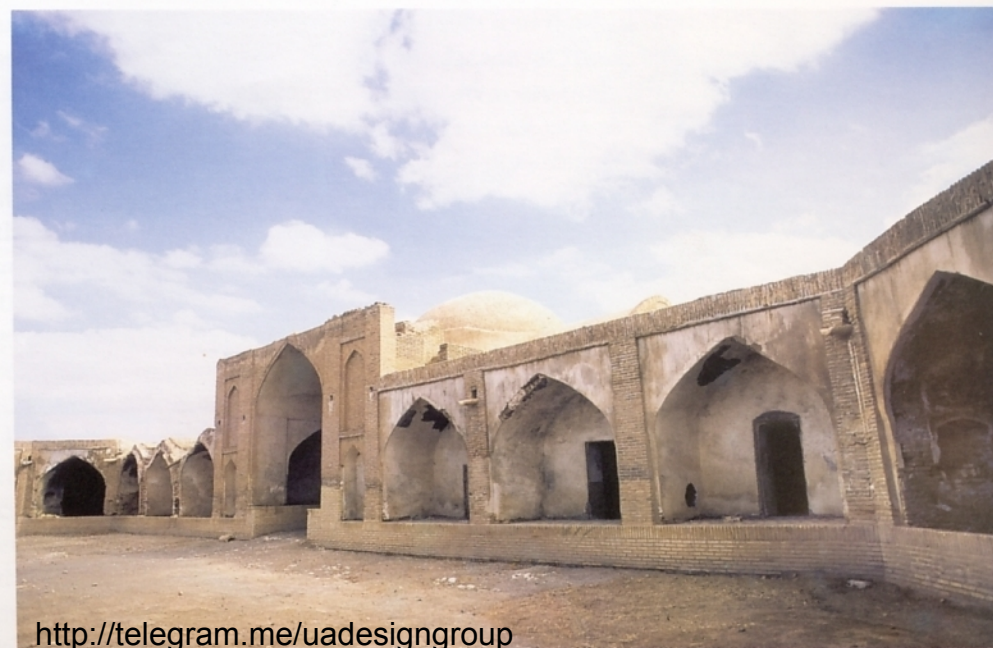
۵۶. جبهه جنوبی حیاط
