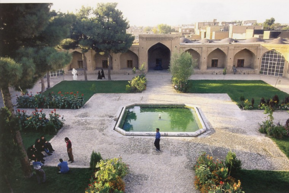
۱۲۵. حیاط و نمای غربی 125. Courtyard and its western facade
