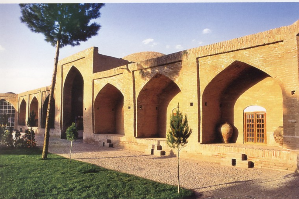
۱۲۶. جبهه شمالی حیاط 126. Northern side of the courtyard
